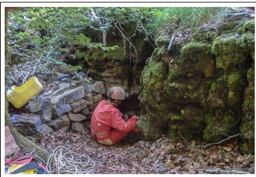
◁ L'entrée de la torca, le muret à gauche laisse imaginer l'ampleur des travaux qui ont débuté dès l'entrée.
